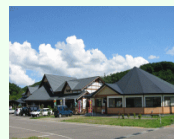
道の駅おりつめ 「オドデ館」
